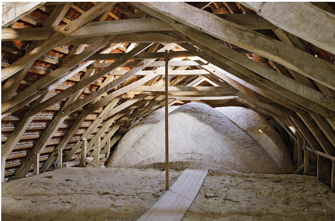
Fig. 11. Kirkens tagværker over kor og skib (s. 2702). Foto Arnold Mikkelsen 2012. – Roofing of the church above chancel and nave.
