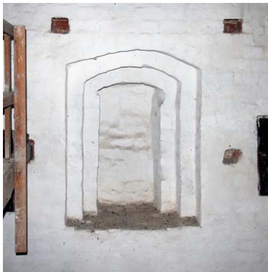
Fig. 9. Blændet sydvindue i tårnets mellemstokværk (s. 2700). Foto Martin Wangsgaard Jürgensen 2012. – Bricked-up south window on the middle floor of the tower.
