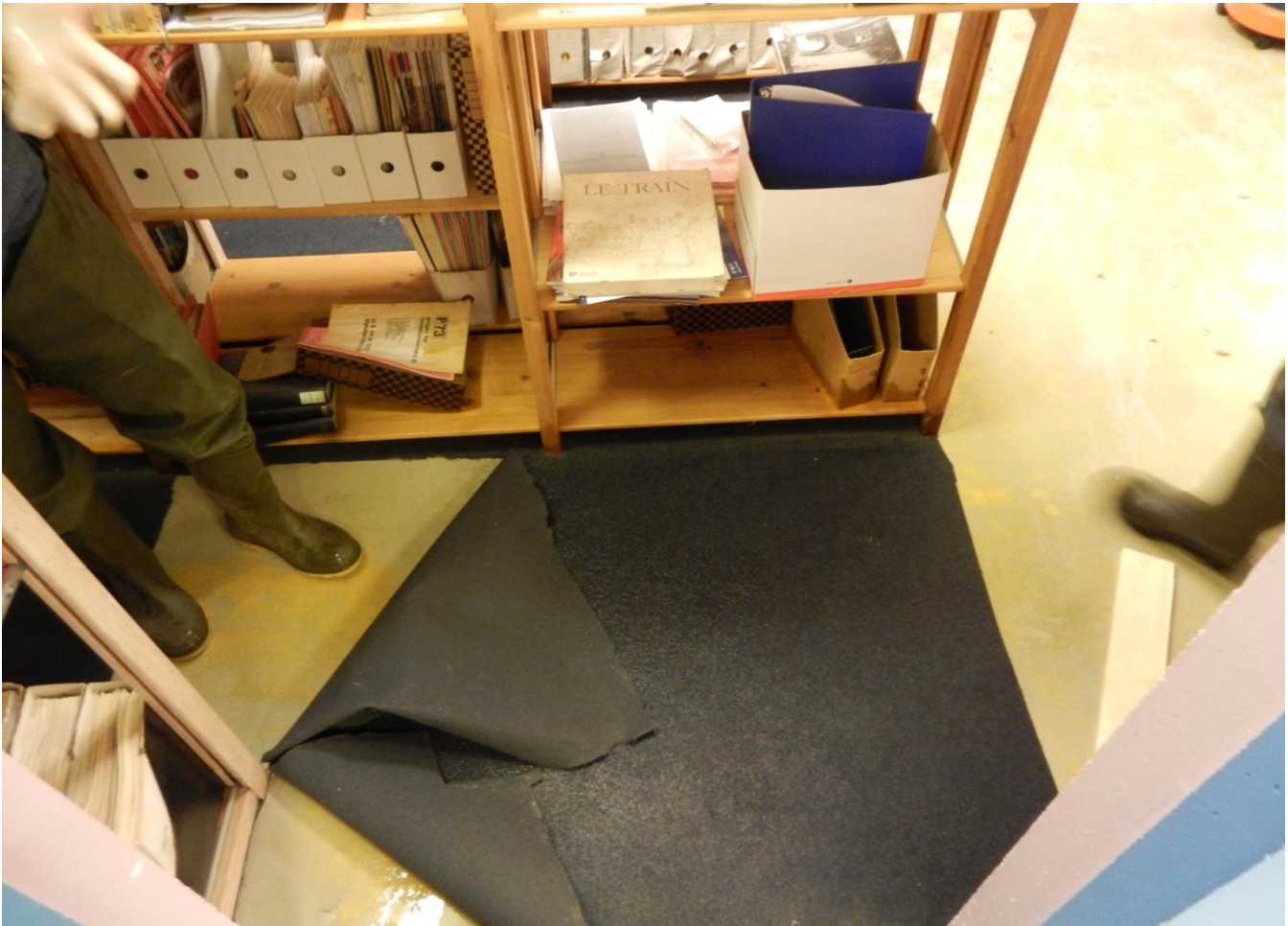
Vores nu knap så fine gulvtæppe blev fjernet, ødelagt af kloakvand!
