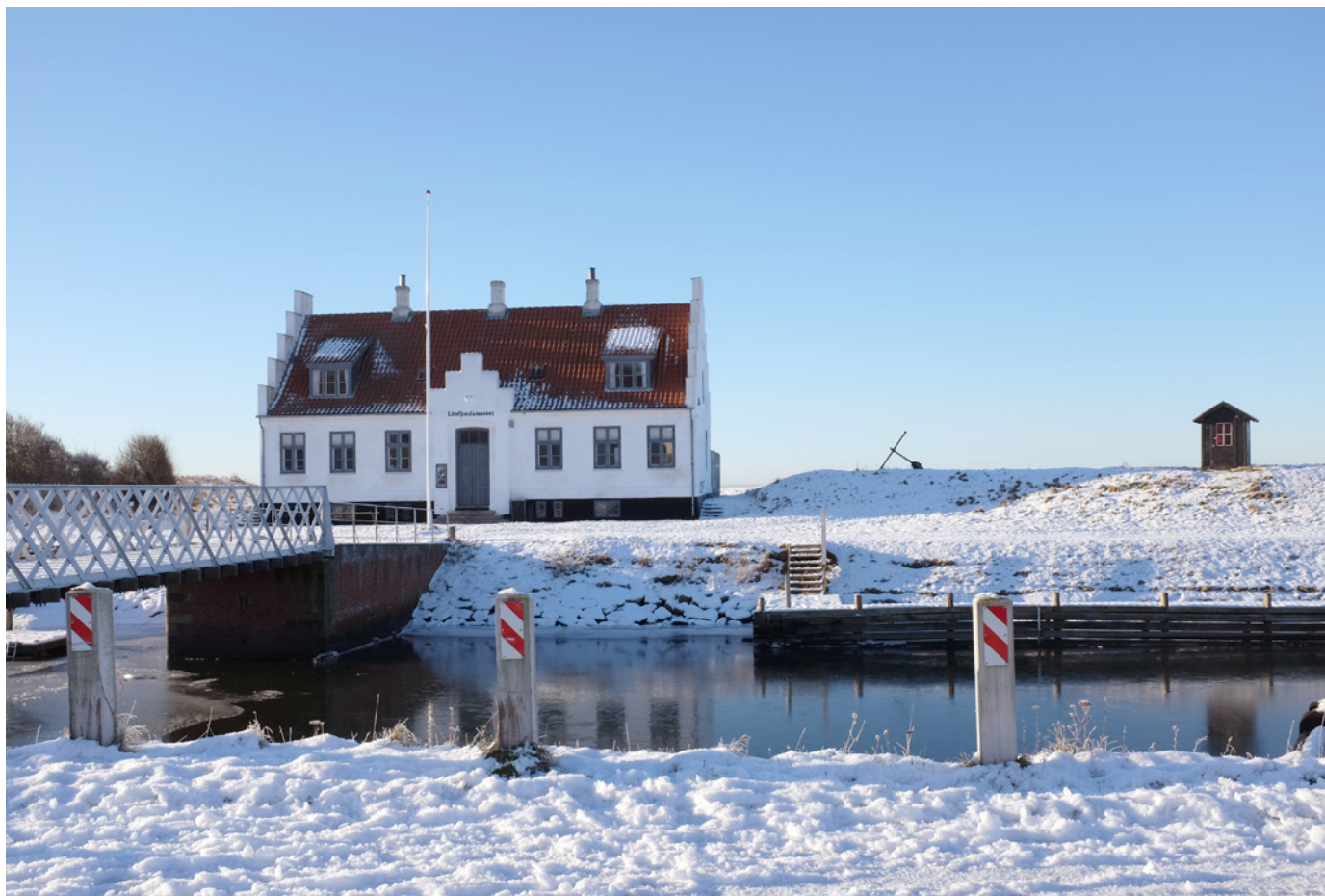
Limfjordsmuseet ved Frederik den VII's Kanal
