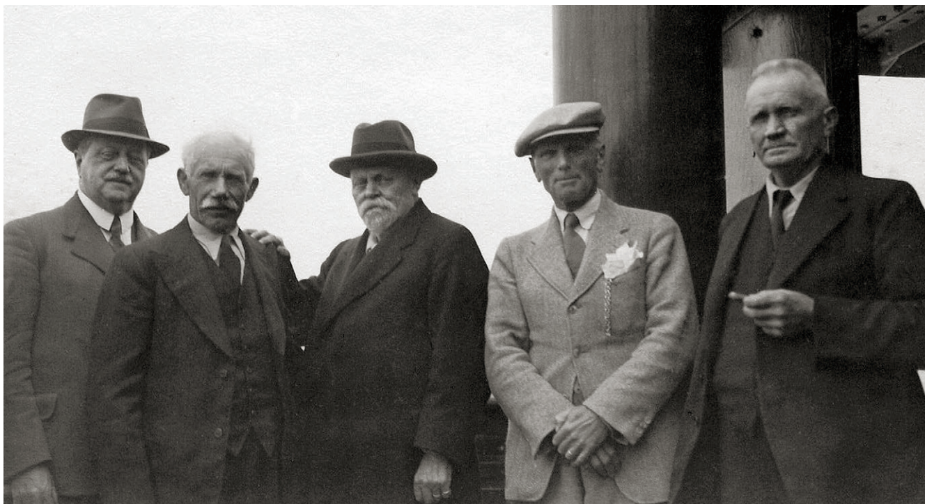
Her er mændene bag den nye pumpestation i 1939. Ingeniør H.M. Markersen står længst til venstre. De øvrige, som utvivlsomt udgør vigtige personligheder på egnen, er i dag glemt. Ingen genkender dem, når man viser billedet frem. Det stammer fra indvielsen af den nye pumpehal i 1943.
