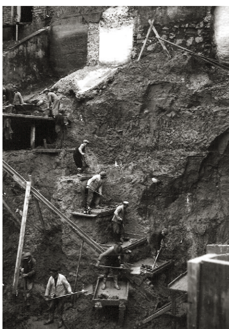
Det nye pumpehus udgraves med håndkraft.
