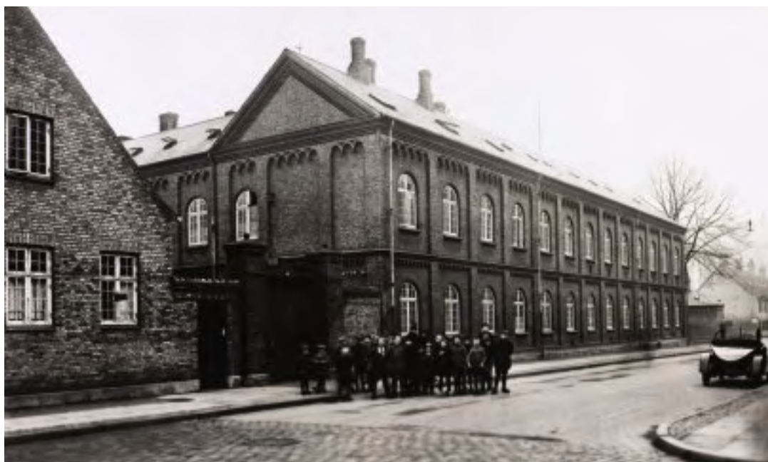
I 1916 blev der opført en ny portnerbolig, der også indeholdt vaskerum.
