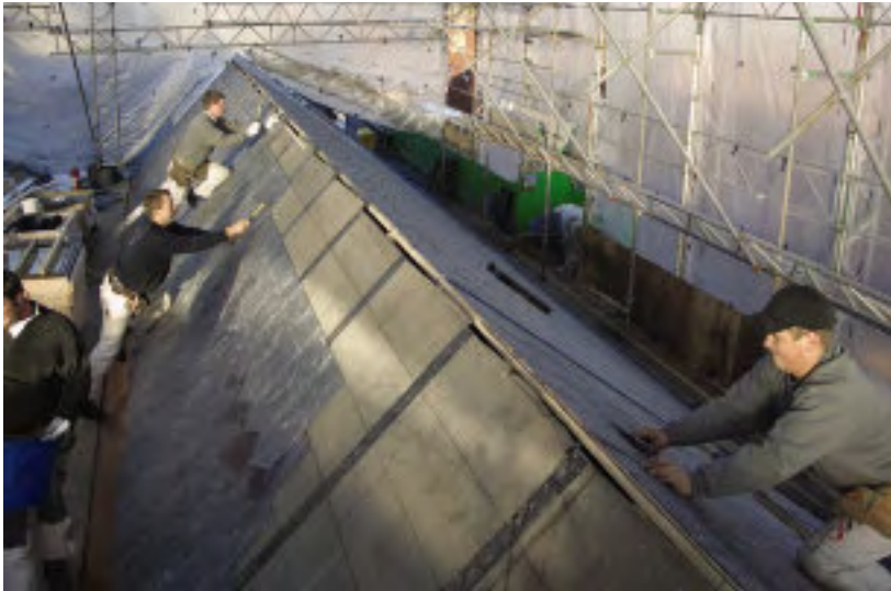
Undertaget for det nye tag lægges.
