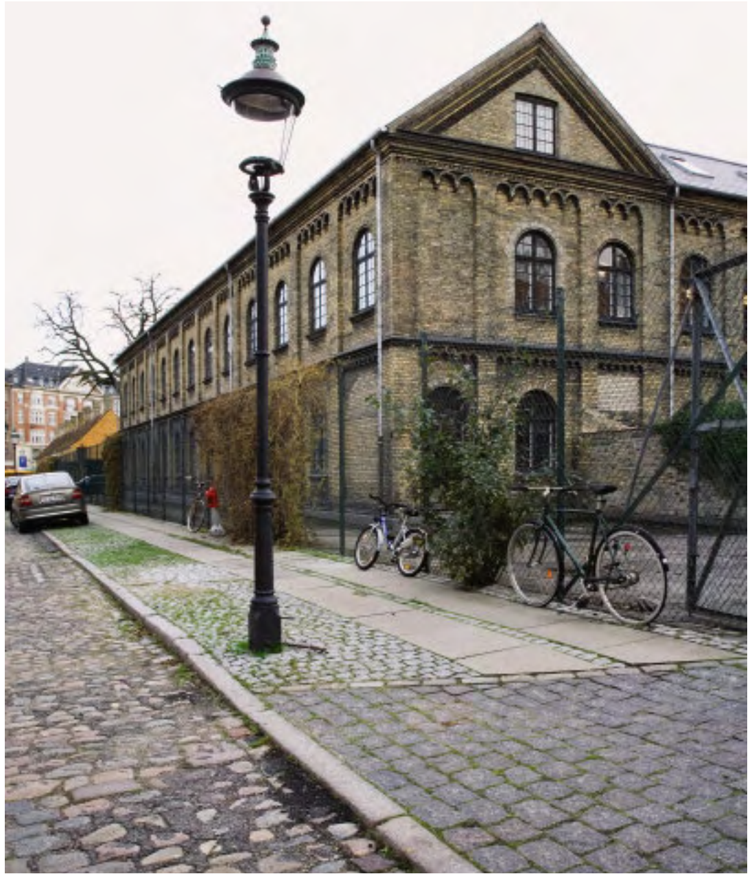
Skolens nordfacade set fra Haregade.
